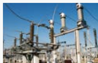
変電所サーベイランス
